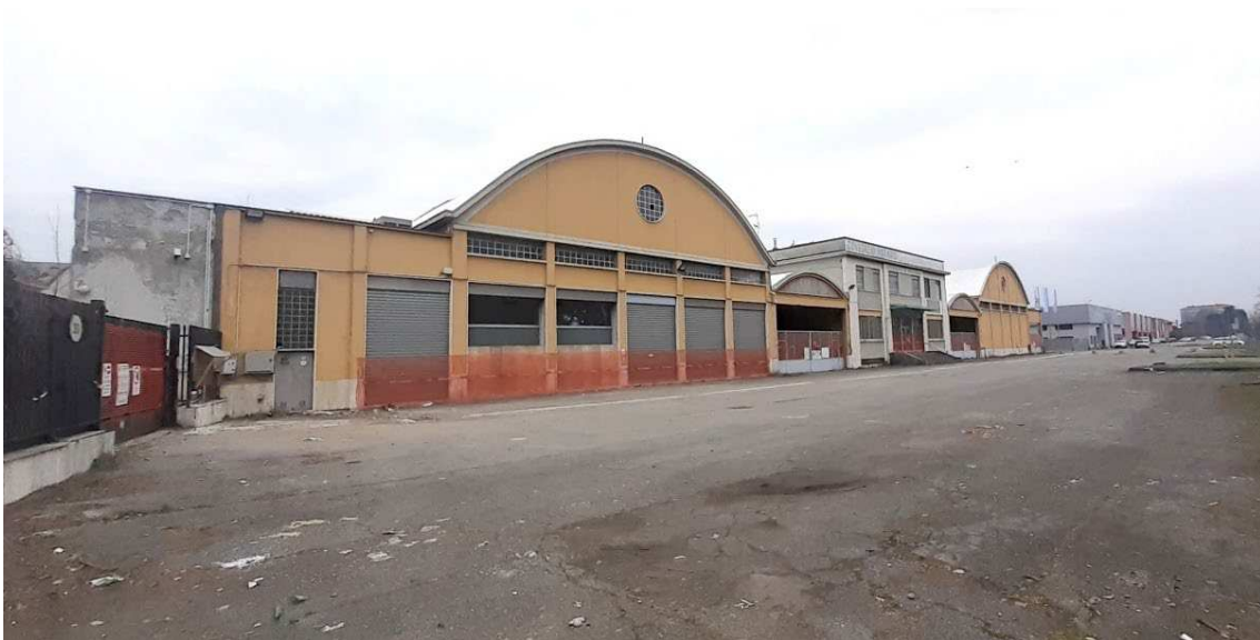
Area ex Consorzio agrario – veduta del fronte da Viale della Repubblica
