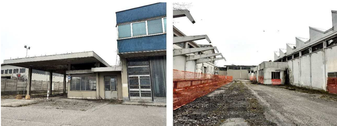
Fabbricati esistenti oggetto di demolizione
